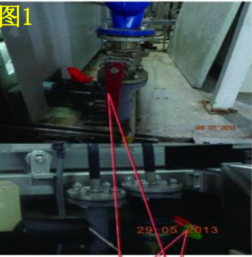
将各蒸汽管道 阀门打开。
