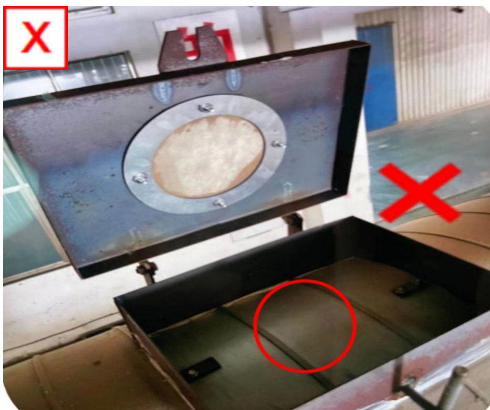
隐患描述:除尘风管未按要求设置清灰口, 设置了虚假清灰口。
