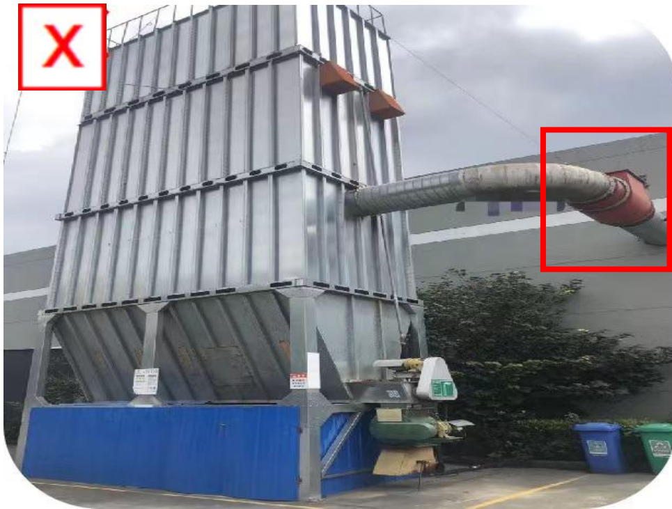
隐患描述：隔爆阀未可靠支撑固定。
