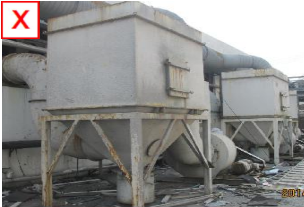
重大隐患描述：金属粉尘除尘系统无任何控爆措施。
