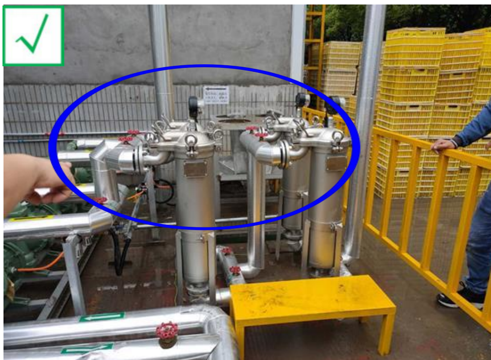
情景描述：湿式除尘水箱过滤器。
